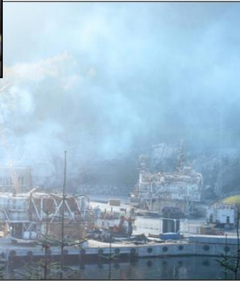
GIFTUTSLIPP: Selskapet AF Decom hogger opp gamle oljeplattformer på Raunes i Vindafjord ved Haugesund. Foto: Privat
